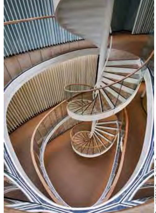
Eine der organisch geformten Treppenhauseanlagen, die als Tageslichtdiffusor wirken
