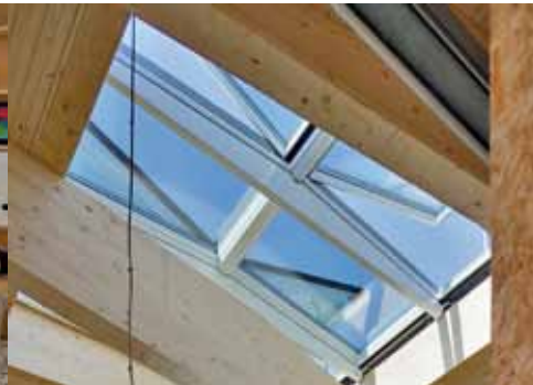
Das modulare Oberlichtsystem versorgt die Wohnhalle mit Tageslicht und Himmelsblick
