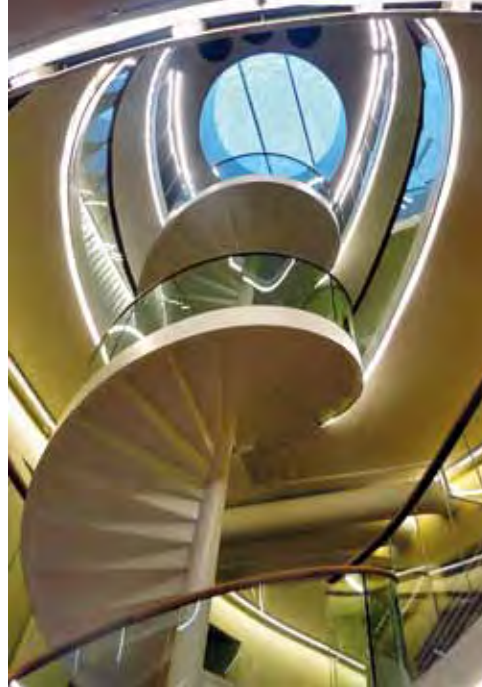
Lichtkuppeln lenken Tageslicht über die organisch geformten Treppenhauseanlagen bis ins EG
