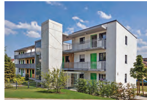
Foto: Johannes Vogt, Mannheim, DE / Sto SE & Co. KGaA
