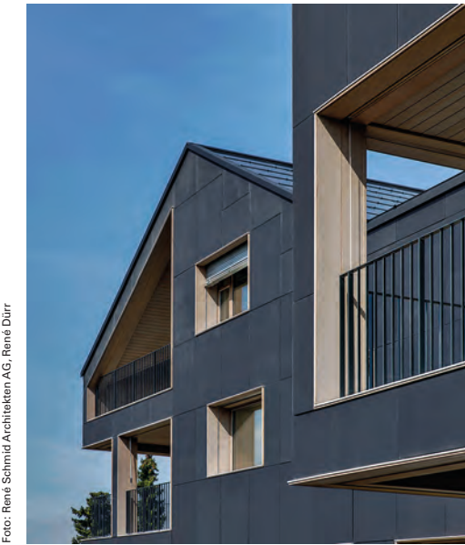
Die gesamte Gebäudehaut liefert Solarstrom
