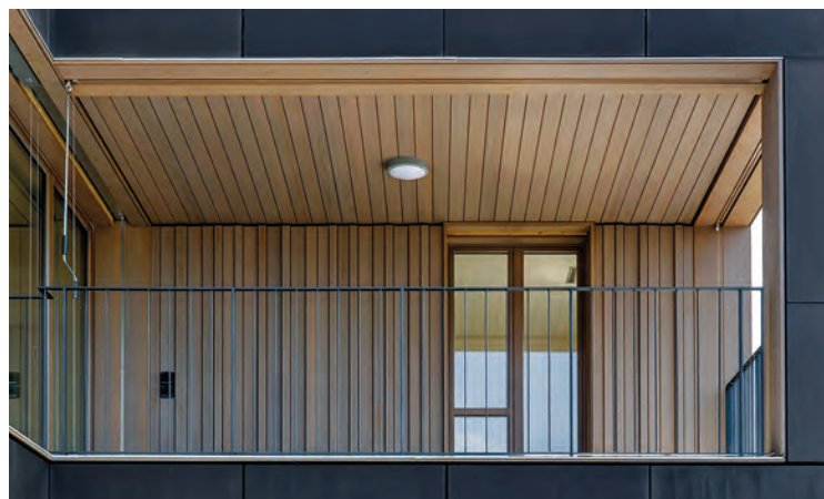
Die eingeschobenen Loggien sind mit Holz ausgekleidet
