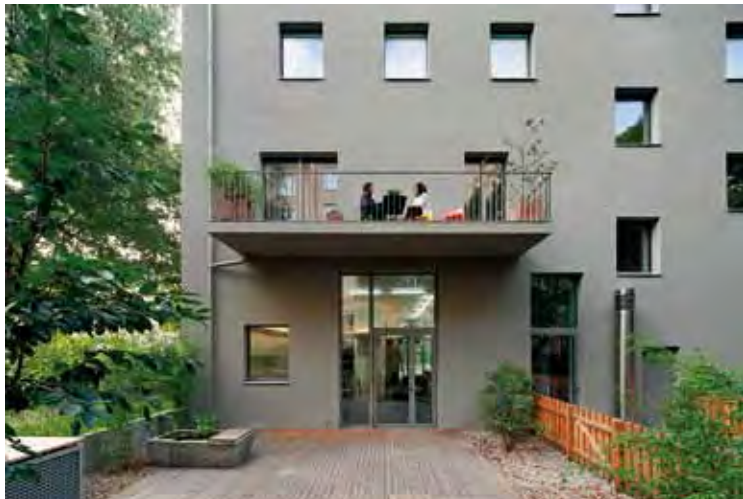
Die frei auskragende, filigrane Bauweise des 7,22 x 1,50 m großen Balkons wurde dank Passivhaus zertifizierter Isokorb-Typen mit einem linearen Wärmebrückenverlustkoeffizient \Psi von lediglich 0,175 W/m K realisiert
