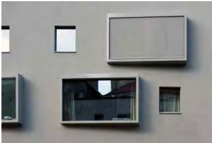
Durch die großen südorientierten Fenster werden solare Wärmegewinne generiert. Ein versteckt im Rahmen integrierter Sonnenschutz schützt im Sommer vor zu viel Wärmeeintrag
