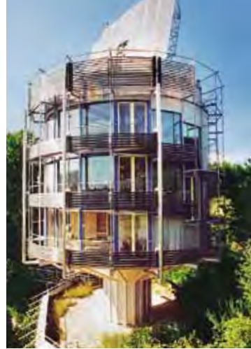
Foto: Rolf Disch Solararchitektur, Freiburg
