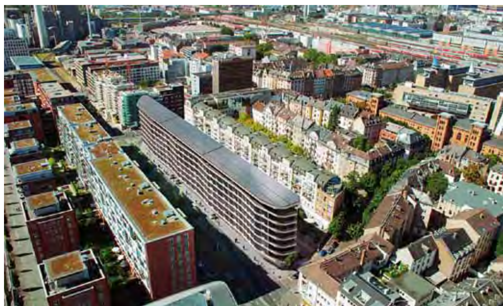
Mehrfamilienhaus Stadt-Aktivhaus in EnergiePlus, Frankfurt a. M. – HHS Planer und Architekten, Kassel
