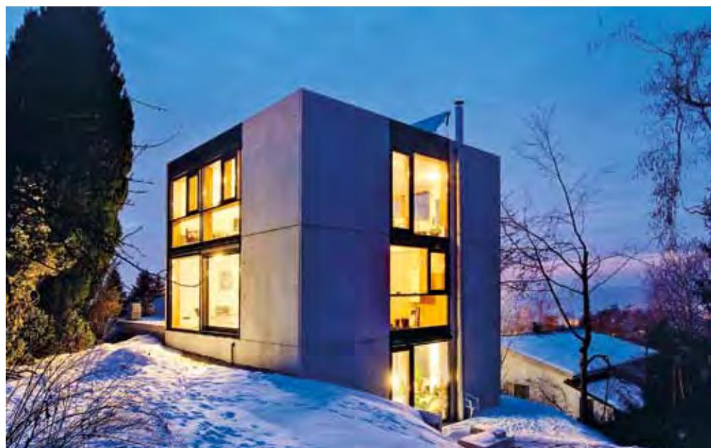
Abb. 5: Wände und Decken aus Betonfertigteilen können wirkungsvoll in das energetische Gebäudekonzept integriert werden. Im Bild ein Einfamilienhaus in Hörbranz – Architekt: Christoph Manahl
