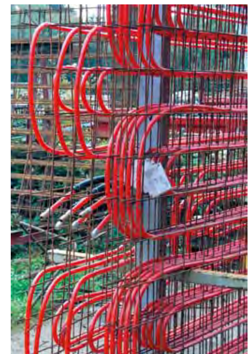
Abb. 6: Vorkonfektionierte Rohrregister für die Betonkernaktivierung ermöglichen den qualitätsgeprüften Einbau im Fertigteilwerk
