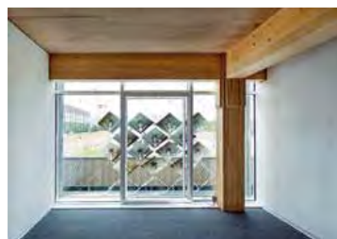
Der Innenraum wird durch die adaptive Fassade verschattet und der dahinterliegende, etwa 15m 2 große Büroraum mit Strom versorgt
