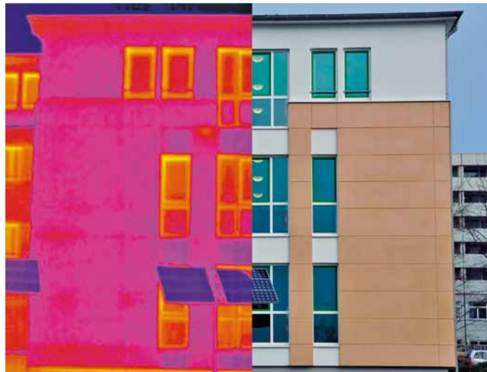
Abb. 4: Thermische Optimierung der Fassade mit Stahlbeton-Sandwichelementen
