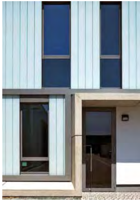
Der Aluminiumrahmen der Glasfenster ist hinter dem Profilglassystem mit TWD angeordnet, so dass sich eine geringe Ansichtsbreite von nur 23,2 cm ergibt
