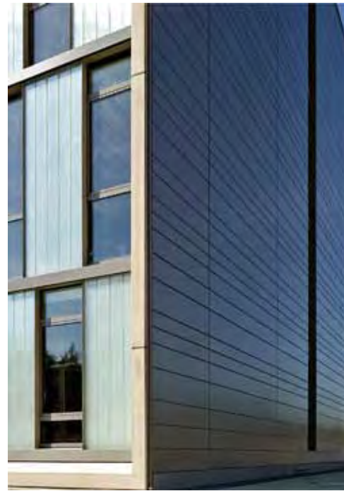
Die Seitenwände wurden mit vorgehängten Metallkassetten verkleidet. Gut zu sehen ist hier auch der geschossumschließende, graue Metallrahmen auf der „Barcode“-Fassade
