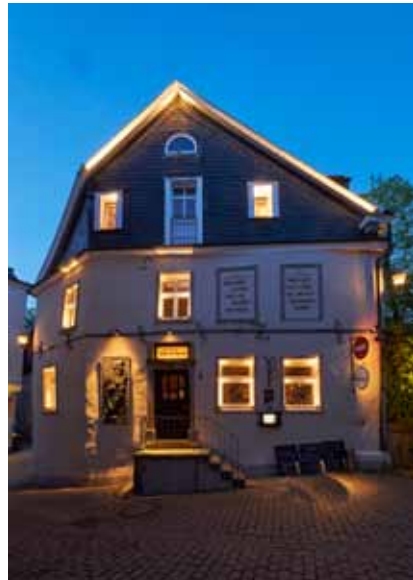
Außenbeleuchtung mit LEDs: Durch präzise Anstrahlung werden die wesentlichen Elemente betont
