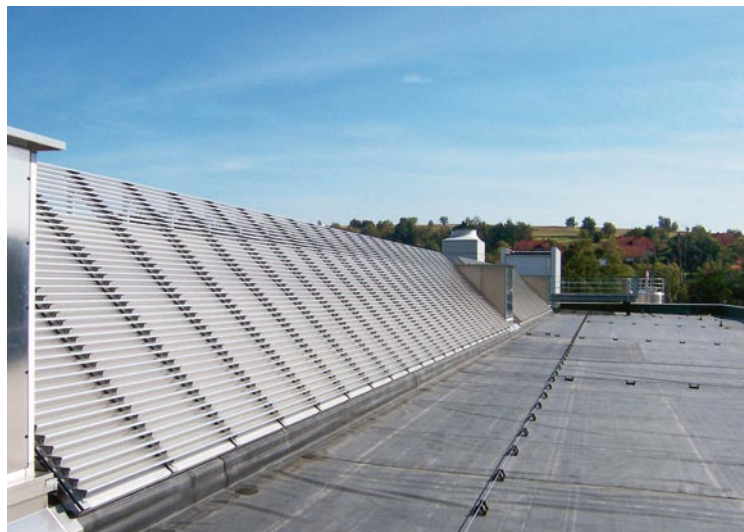
Der Tageslicheinfall wurde durch starren Sonnenschutz an den Lichtstraßen optimiert
