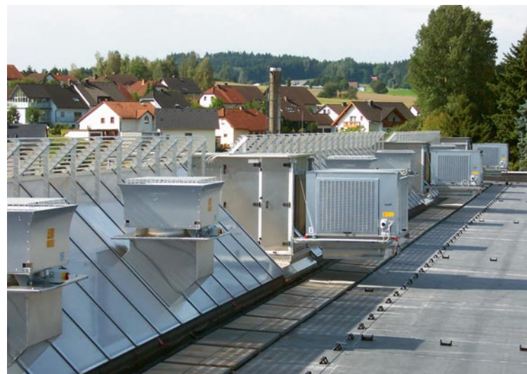
Die CoolStream-Einheiten wurden mit natürlichen und mechanischen Lüftungsanlagen und einer Tageslichtlösung kombiniert
