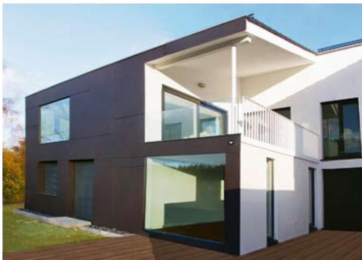
Das Foto zeigt die drei ausgeführten Wandkonstruktionen: die Paneelfassade, Holzständerwand am Wintergarten und Putzfassade mit WDVS
