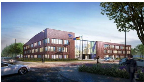
Abb. 6: Neues Betriebsgebäude Brunsbüttel der Wasserstraßen- und Schifffahrtsverwaltung des Bundes: Baubeginn war im März 2022, die Abnahme erfolgte im Oktober 2023. Besonderheiten sind ein klimaneutraler Betrieb, eine hohe Energieeffizienz, ein regenerativer Fernwärmeanschluss und eine vollflächige PV-Anlage auf dem Hauptdach. (Darstellung: Fa. GOLDBECK Public Partner GmbH).
