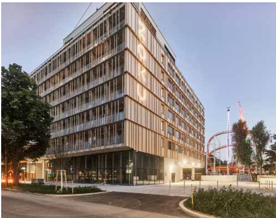
Am Prater in Wien haben Superbude und Zoku die Pforten für Städtereisende und Remote-Arbeitende geöffnet: Das Gebäude besteht aus zwei transparenten Sockeln, darüber überspannen die Zimmergeschosse den Busparkplatz der Messe Wien. Im Dachgeschoss befinden sich zwei Rooftop-Bars mit atemberaubendem Ausblick auf den Prater und die Wiener Innenstadt
